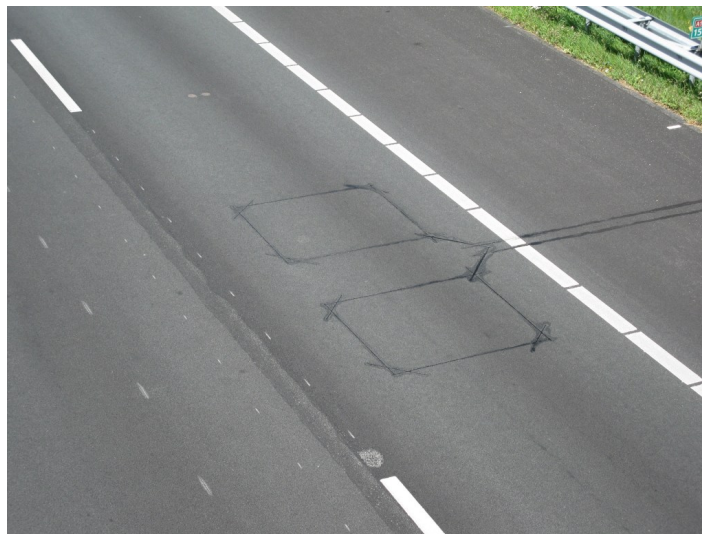
Rysunek 2.5. Pętle indukcyjne umieszczone w nawierzchni jezdni wykorzystywane do pomiarów prędkości przejazdu pojazdów. Źródło: [40]
